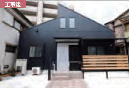
荒川区 築40年 H邸のリフォーム事例。3階建てだった事務所兼住まいを減築し、構造躯体への荷重も減少
